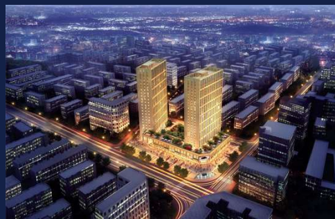
杭州翔腾财富中心
