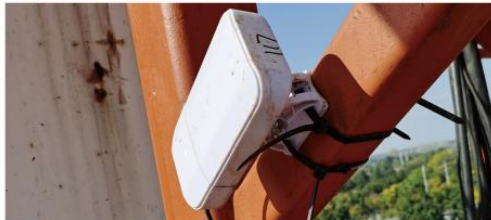
图13 接收网桥安装
