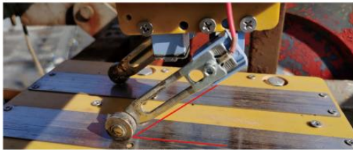
图10 充电桩触点安装标准图
