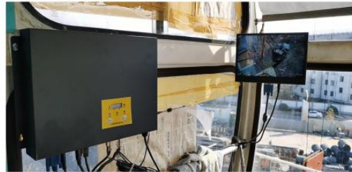
图12 显示器及主机安装图
