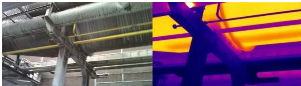
管道健康检测
