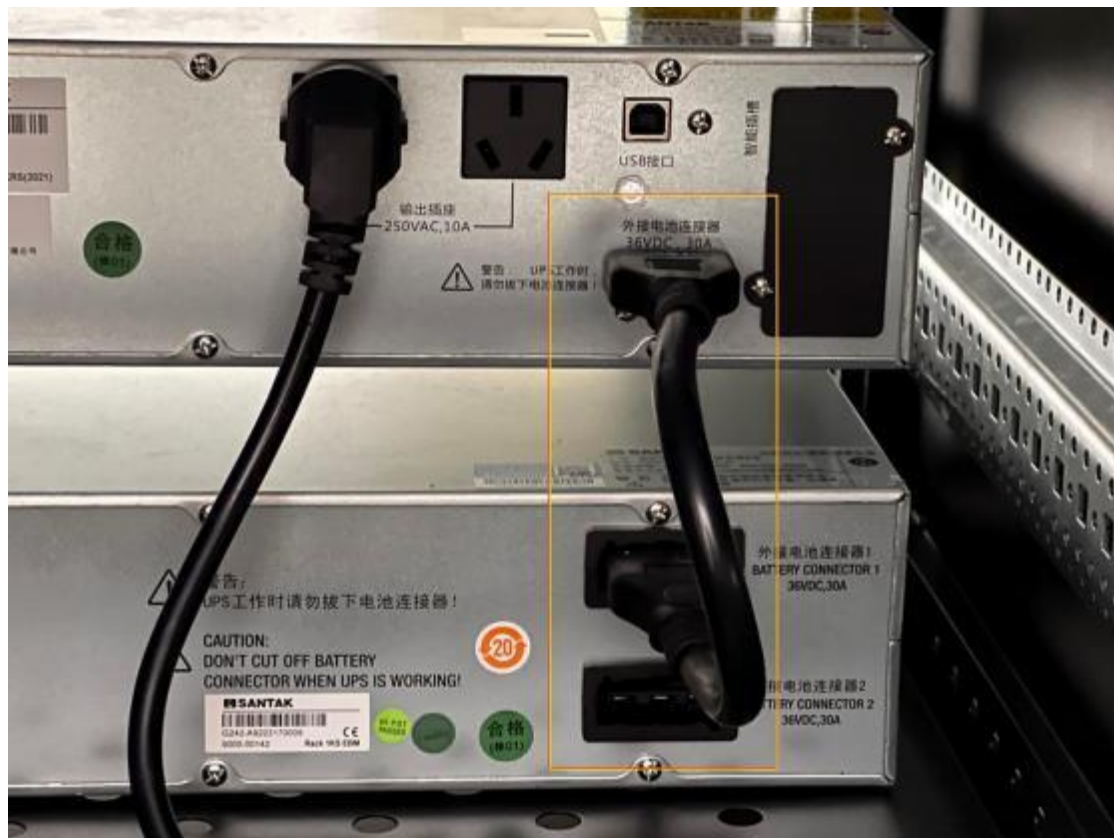
图 6 电池电源连接
