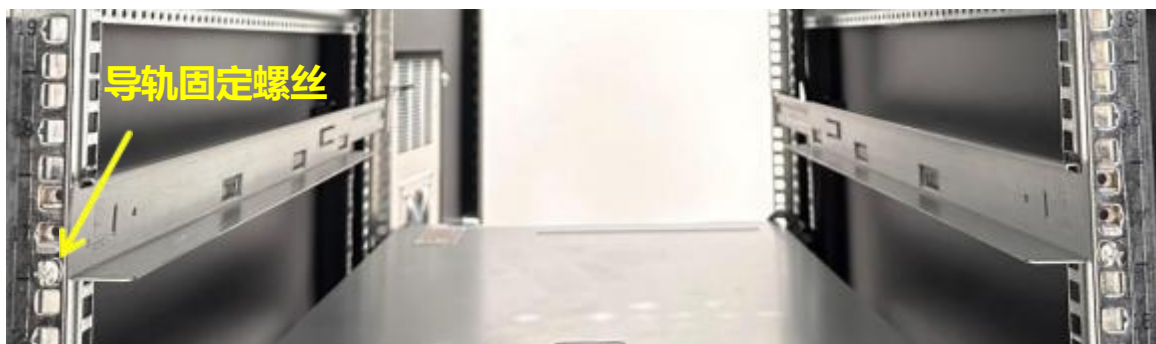
图 10 导轨安装
