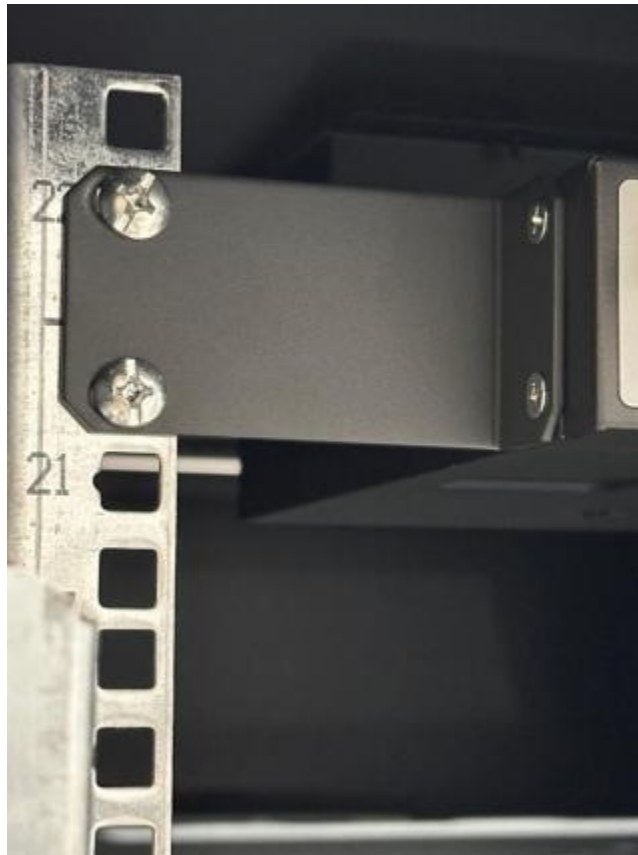
图 13 交换机扩展板
